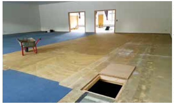
Der Umbau der KÖB St. Heinrich Reken-Groß-Reken
